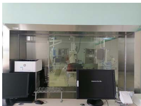
图4-11 控制室铅玻璃
